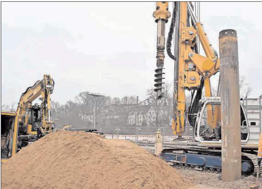
Tiefe Löcher werden gebohrt, in die Stahlträger eingesetzt werden: Die Firma Geschwister Balter aus Losheim arbeitet als Subunternehmen für das Bauunternehmen Albert Fischer an der Baugrubensicherung.
